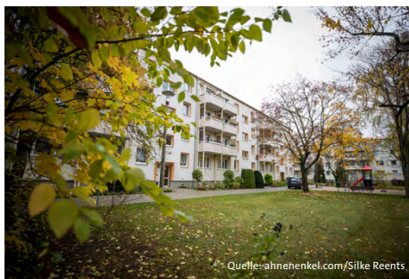
Abbildung 3: Gebäude des Modellquartiers
