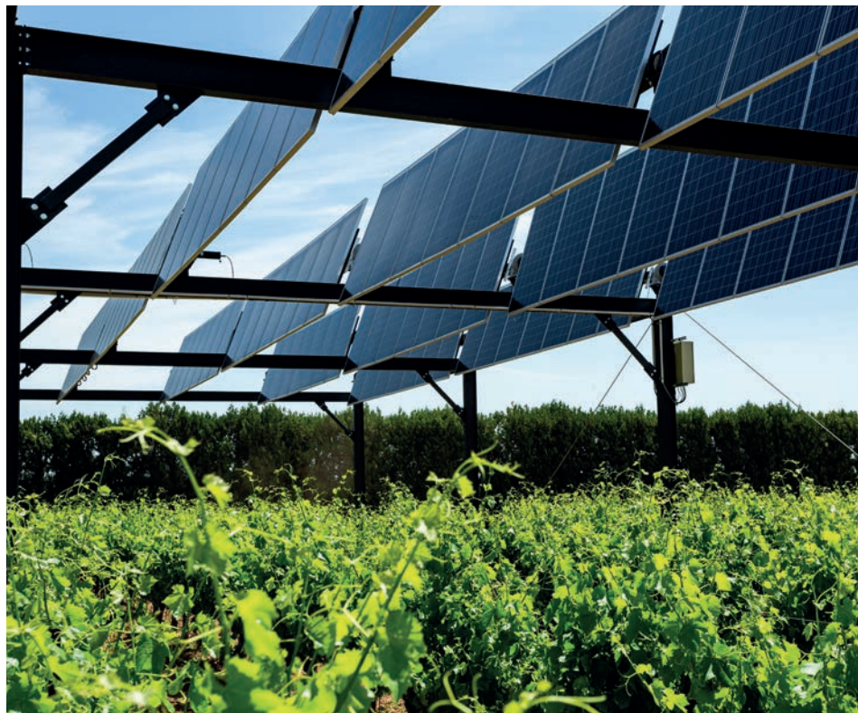
Abb. 45 Einachsiges Tracker-system einer Demonstrations-anlage in Frankreich. © Sun'Agri
