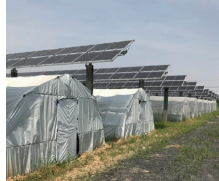
Abb. 40: PV-Module über einem Folientunnel. © BayWa r.e.
