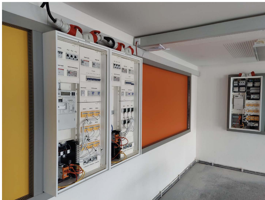
Abbildung 17: Laboraufbau in „dena-BMIL-Konfiguration“ (Quelle: Eigenes Bild YOUKI GmbH)
